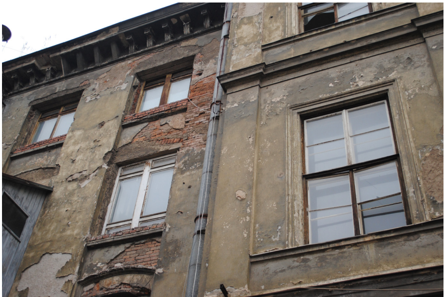
instalace - pohled ze dvora
